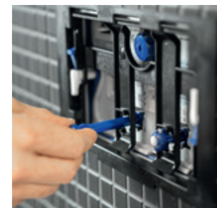
6 Vervolgens brengt hij ze op de juiste lengte in en zet ze vast met een draaibeweging van 90°.
