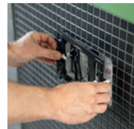
3 Het oude montageframe kan gemakkelijk worden verwijderd door de afstandsbouten 90° te draaien.
