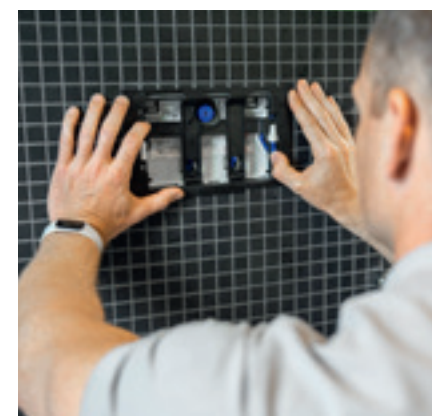
4 Het nieuwe Sigma40 montageframe wordt op zijn plaats gezet, vastgezet met de afstandsbouten en vastgedraaid met de borgpennen.
