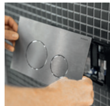
7 Nu komt de laatste stap: de Sigma40 bedieningsplaat wordt in het montageframe geklikt. Een duidelijke klik wanneer de plaat wordt ingedrukt geeft aan dat het klikmechanisme correct is vastgeklikt.
